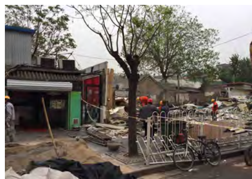
西长安街街道办事处拆除西单横二条违建过程
