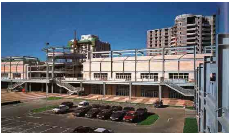
建设大悦城之前的临时性商业建筑——西单科技广场
